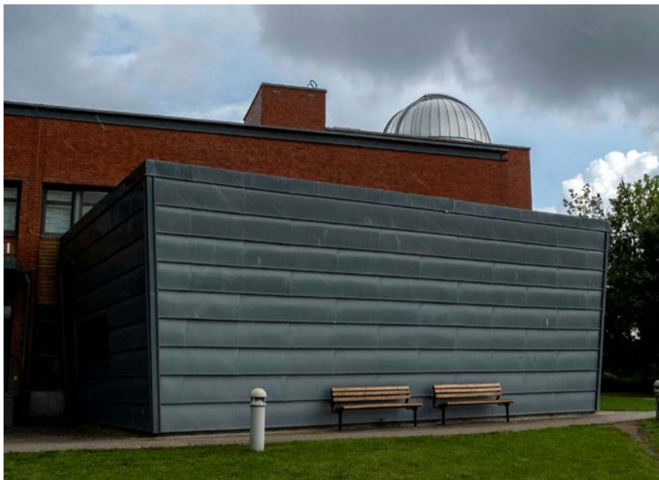
Kupolen på taket är vridbar och kan öppnas mot himlen. Den skyddar teleskopet från väder och vind.
